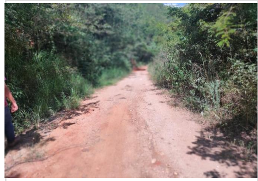
Ladeira de Abel- córrego da Areia
